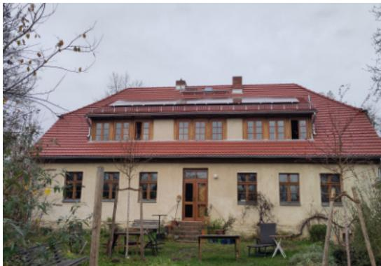
Die Südseite des Pfarrhauses wurde neu eingedeckt und dabei sind auch energetische Sanierungsmaßnahmen, wie die Dämmung der obersten Geschossdecke vorgenommen worden. Eine denkmalgerechte kleine PV-Anlage ist ebenfalls installiert worden. Ein Dank an den Bauausschuss, besonders an Olaf Lindenau, der dieses Projekt sehr engagiert begleitet hat.
